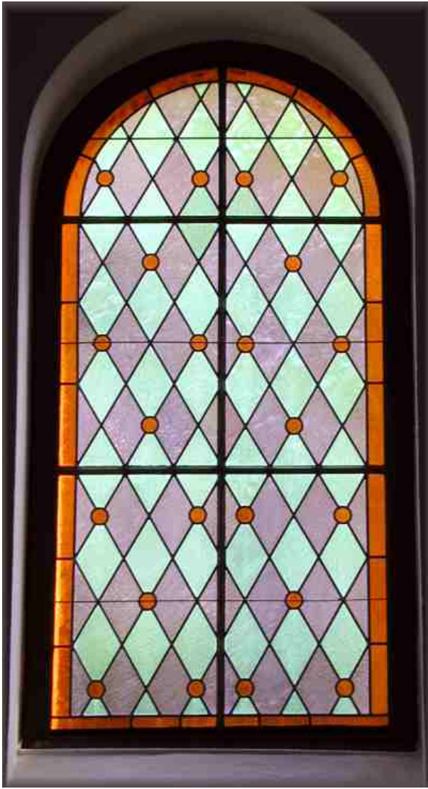
Eines der Fenster noch in Originalverglasung.
