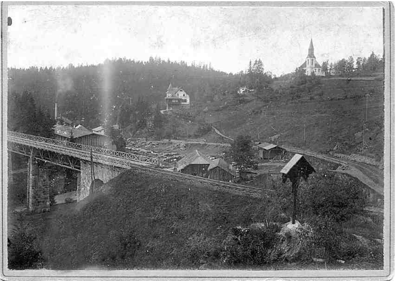
Die Eisenbahnbrücke, dahinter ein Teil der Petzold-Fabrik, rechts oberhalb die Petzold-Villa und noch einige Meter höher rechts daneben die Martin-Luther-Kirche.
