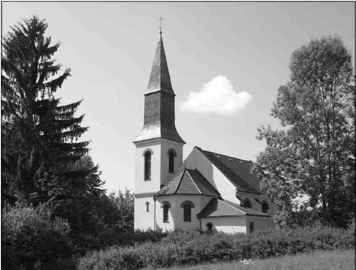
Endlich sind die Sanierungsarbeiten abgeschlossen und das Kirchlein erstrahlt in neuem Glanz.
