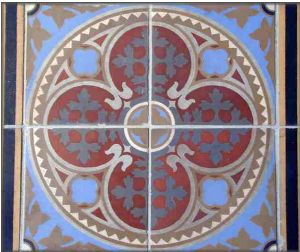
Noch im Original erhaltene Bodenmosaikfliesen.
