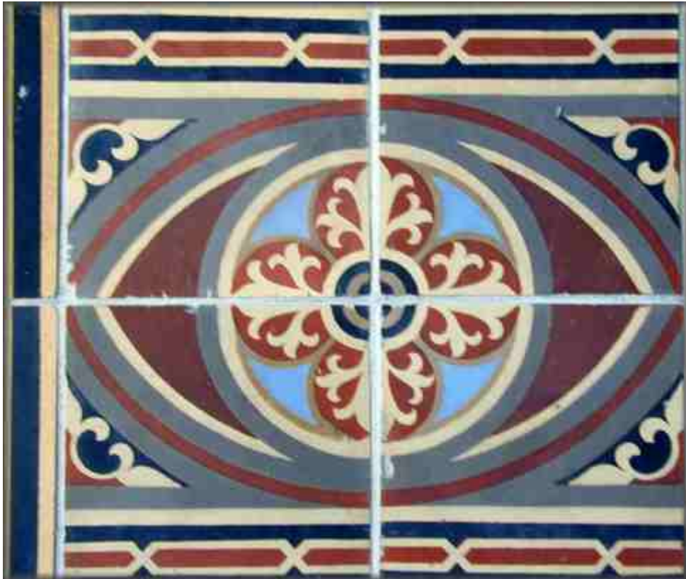
Noch im Original erhaltene Bodenmosaikfliesen.
