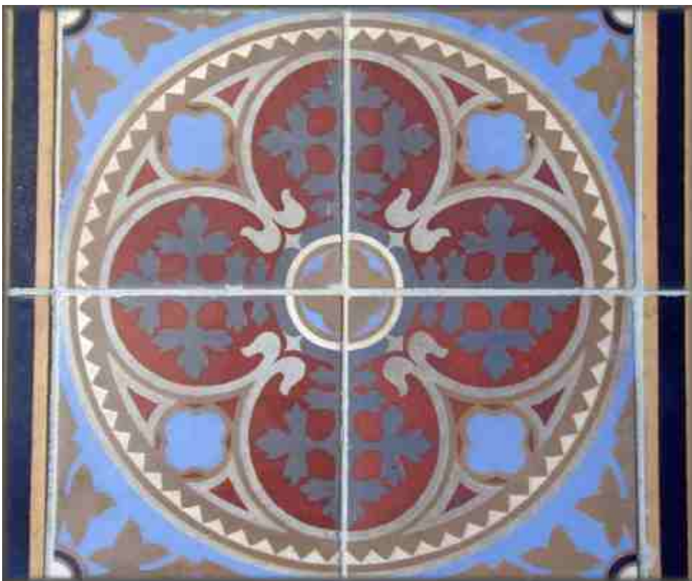
Noch im Original erhaltene Bodenmosaikfliesen.
