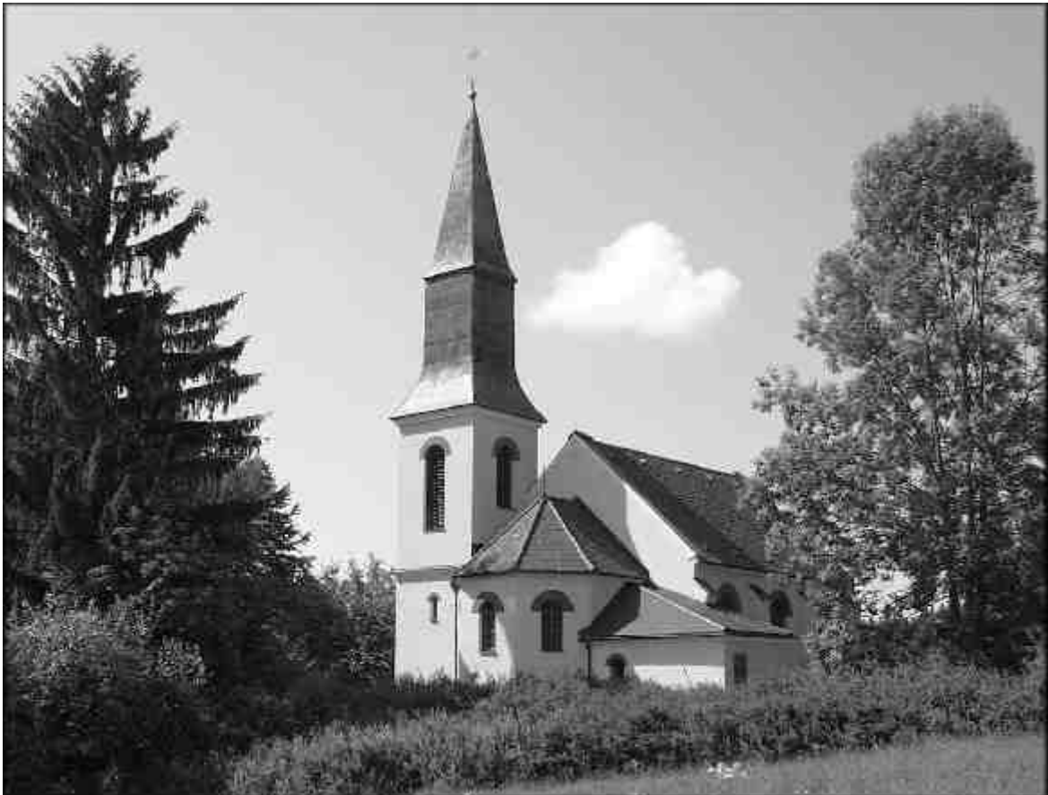
Endlich sind die Sanierungsarbeiten abgeschlossen und das Kirchlein erstrahlt in neuem Glanz.
